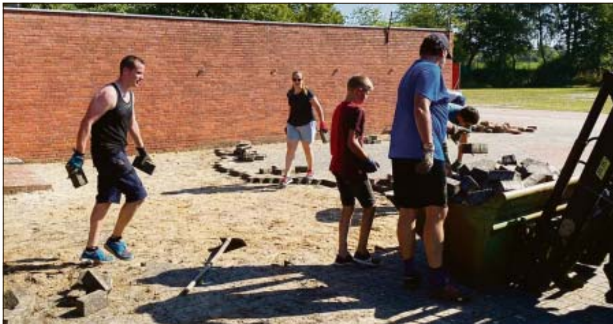
Alle packten kräftig mit an: Die Pflastersteine wurden herausgenommen und auf Paletten gestapelt. Das Verlegen des neuen Pflasters übernehmen im Anschluss die Profis.
